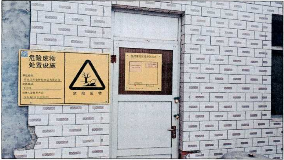
图 3.2-2 危险废物治理情况现场照片
